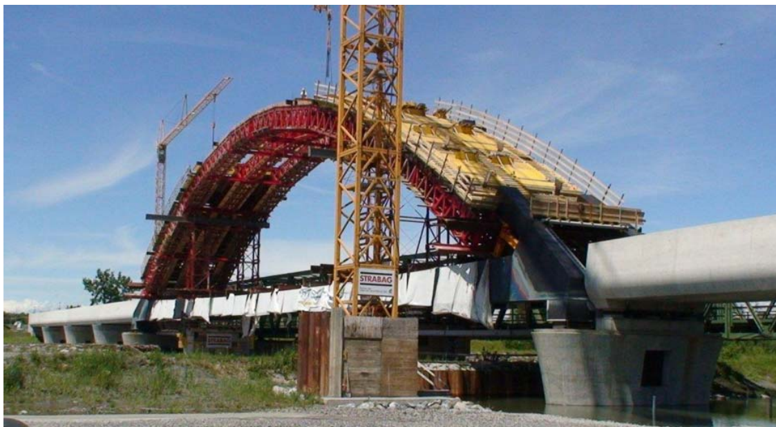
Abb.10: Neue Eisenbahnbrücke über den Rhein mit integriertem Schallschutz Quelle: ÖBB
