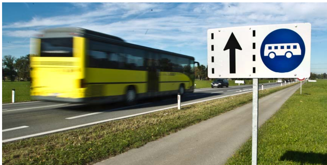
Abb. 9: Umgesetzte Busbeschleunigungsmaßnahmen im Bereich Dornbirn Nord Quelle: Philip Steuerer (VN)
